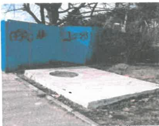
Stația Tineretului – cămin debitmetru
