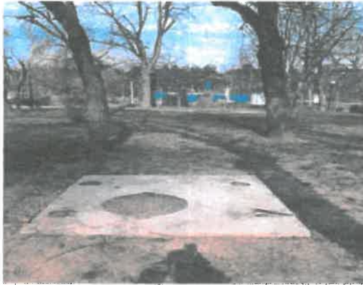
Cămin dren nou pentru by-pass în canalizare Cămin dren nou pentru by-pass în canalizare
