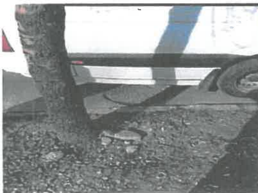
CC1 placa la nivel asfalt
