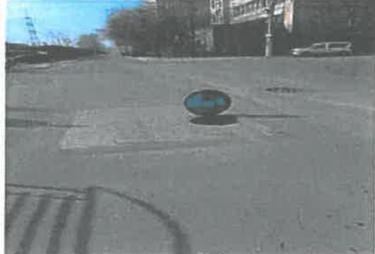
CC3 placa la nivel asfalt
