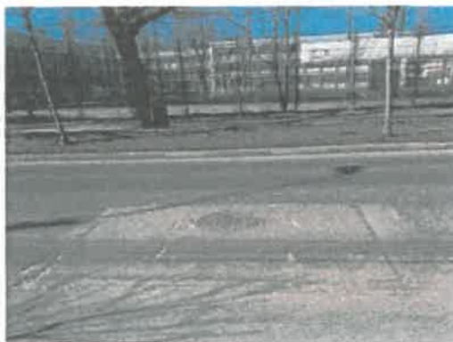
CC2 placa la nivel asfalt
